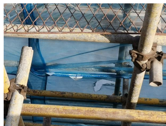
图六外立网“7”字形孔洞图
