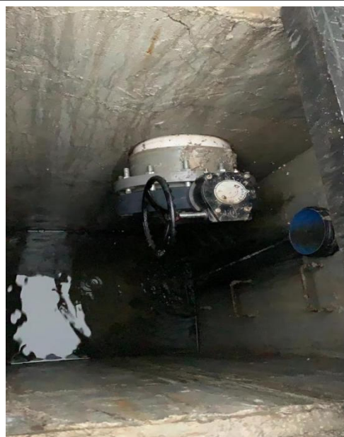
应急池与雨水管网切换阀
