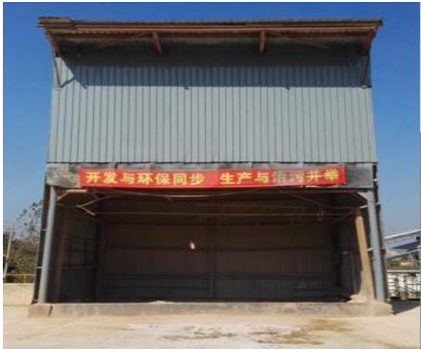
破碎站进料口封闭和喷淋设施
