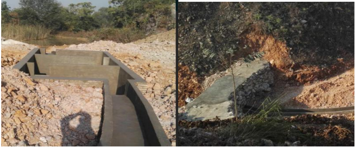
图 4 排土场挡土墙、截排水沟
