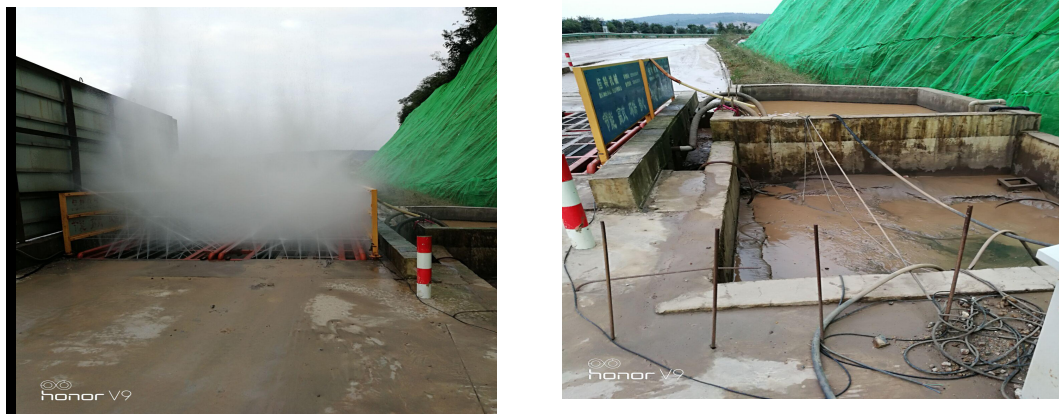
图 8-2 矿山车辆冲洗设施及沉淀池
