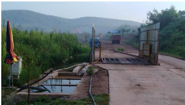
图 8-1 矿山车辆冲洗设施及沉淀池
