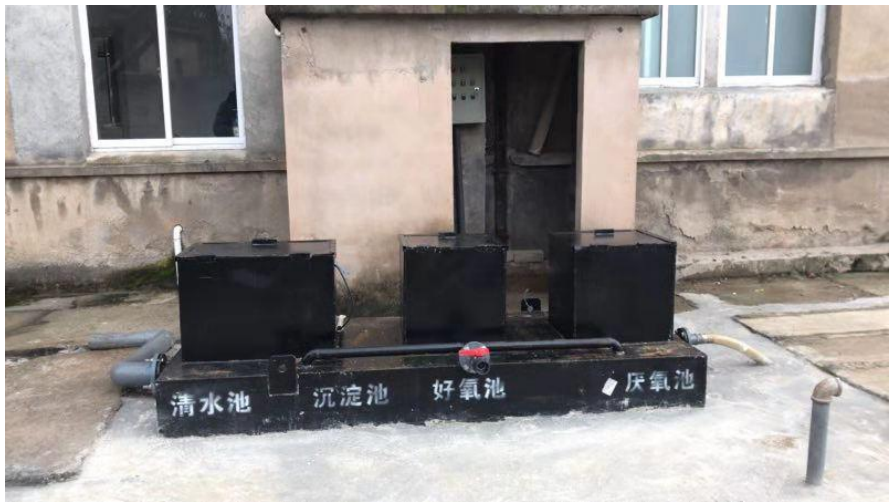
地埋式污水处理装置
