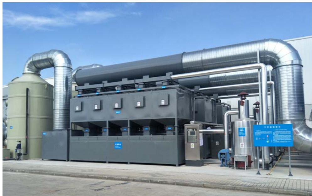
图 6 油漆废气处理设备示意图
