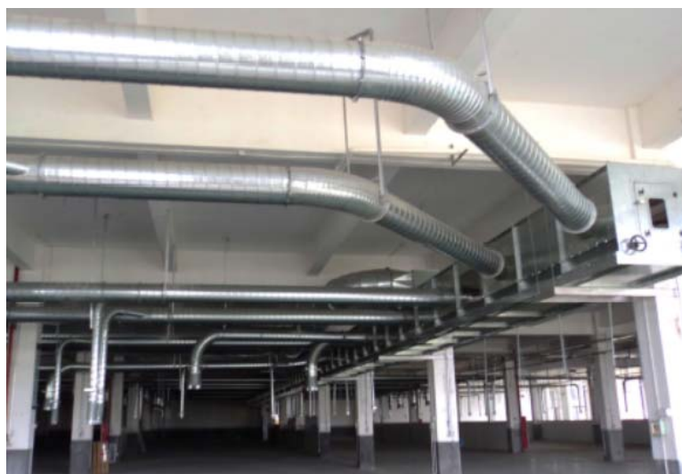
图 2 除尘系统风管收集示意图
