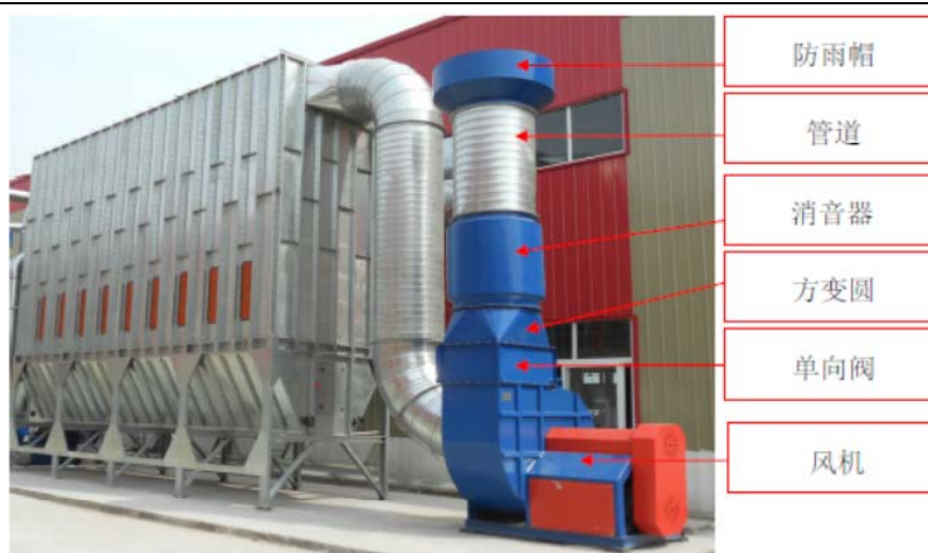
图 3 除尘器示意图
