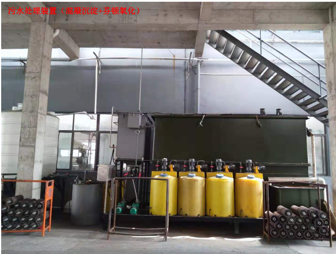
污水处理装置（混凝沉淀+芬顿氧化）
