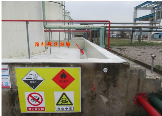
溶剂罐区围堰及内部防腐
