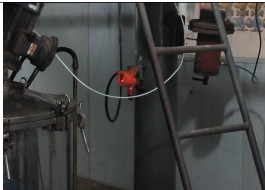
水杨腈可燃气体应急报警装置
