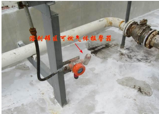
溶剂罐区可燃气体报警器
