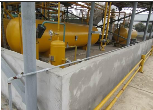
液氨罐区围堰
