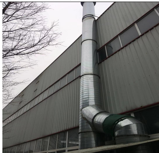
气动打磨机自带除尘设备
