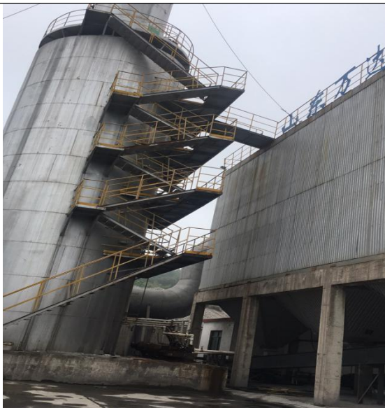
4#窑旋风+布袋+单碱法废气处理设备
