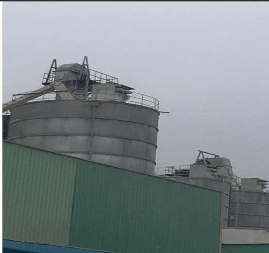
部分成品仓库顶除尘器（共 18 套）
