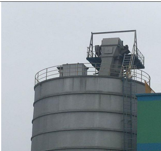
部分成品仓仓顶除尘器（共 18 套）
