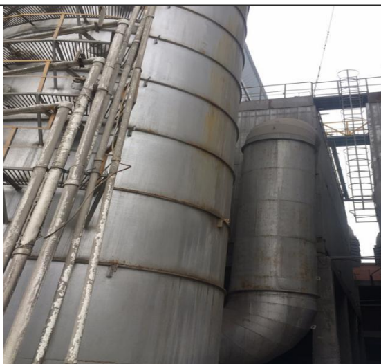
2#窑旋风+布袋+单碱法废气处理设备
