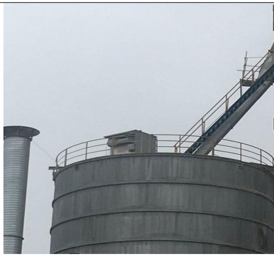
部分成品仓仓顶除尘器（共 18 套）
