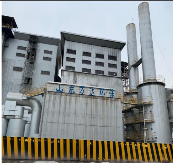
3#窑旋风+布袋+单碱法废气处理设备（2套）
