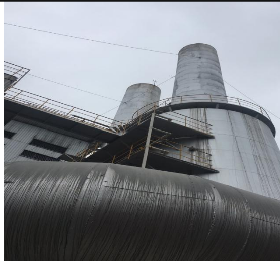
3#窑废气排气筒（2根）
