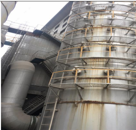
1#窑旋风+布袋+单碱法废气处理设备
