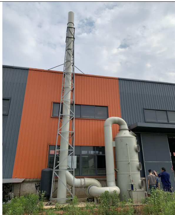
图 4-2 酸性废气处理设备
