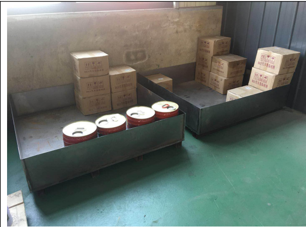
图 4-8 化学品库防渗漏托盘
