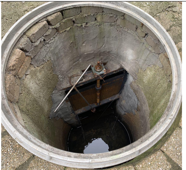
图 4-11 雨水管网切断阀
