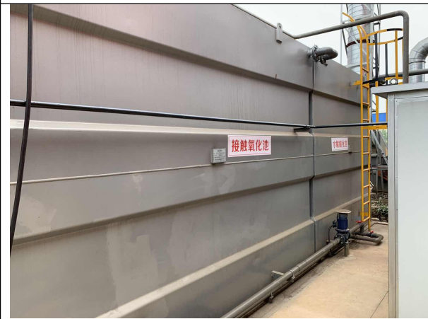
水解酸化池、接触氧化池
