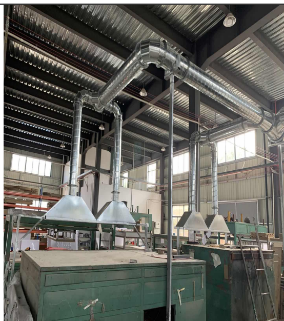
加热废气收集装置
