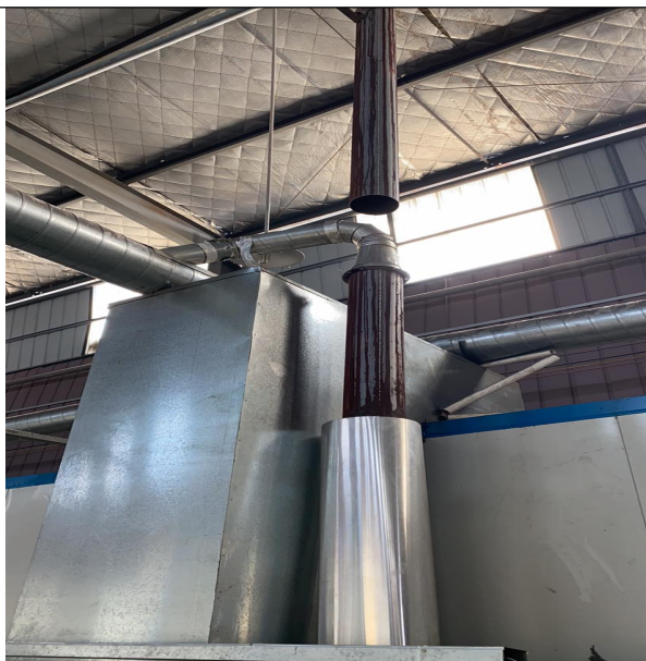
板材喷涂车间废气收集管道
