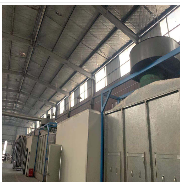
板材喷涂车间废气收集管道
