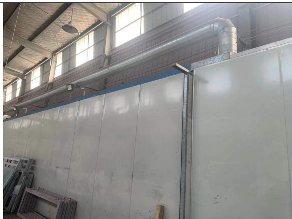
烘房废气收集管道
