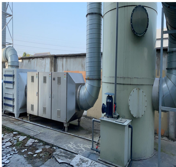
涂料生产废气处理装置（喷淋+水汽吸附+UV 光氧+活性炭吸附）
