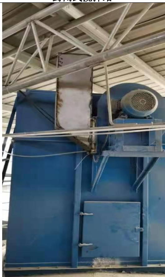
仓顶布袋除尘器、1#排气筒、3#排气筒
