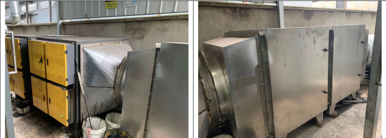
开炼、挤出、硫化、固化废气处理装置
