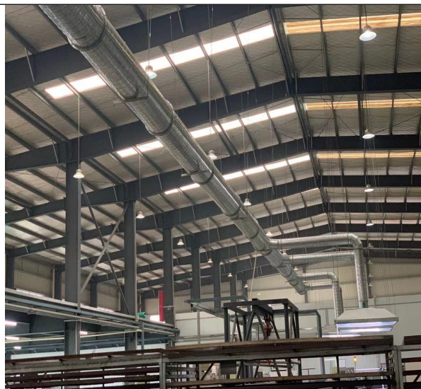
挤出机、开炼机废气收集管道
