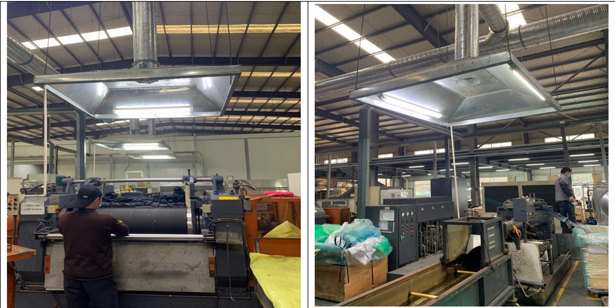
开炼机、挤出机废气收集措施
