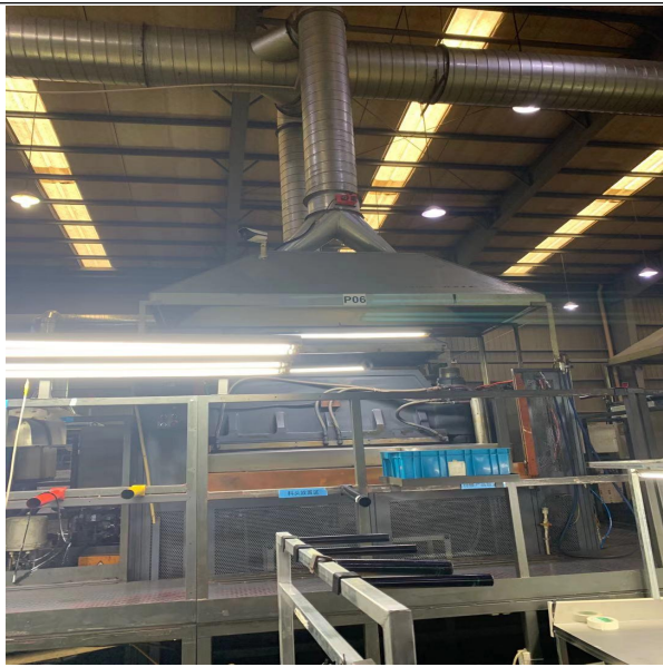
压力机、硫化机废气收集措施
