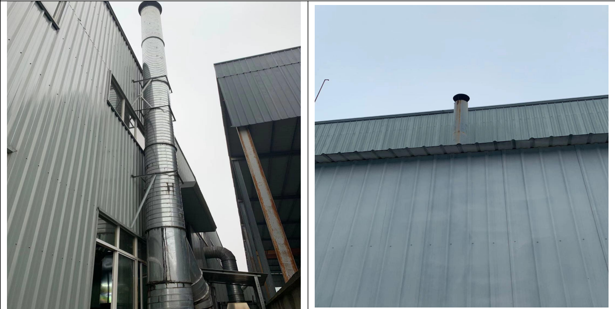
开炼、挤出、硫化、固化废气排气筒
