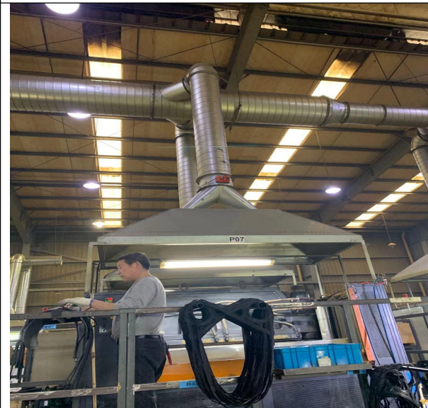
压力机、硫化机废气收集措施
