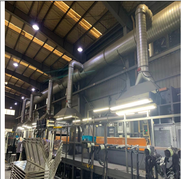
压力机、硫化机废气收集措施
