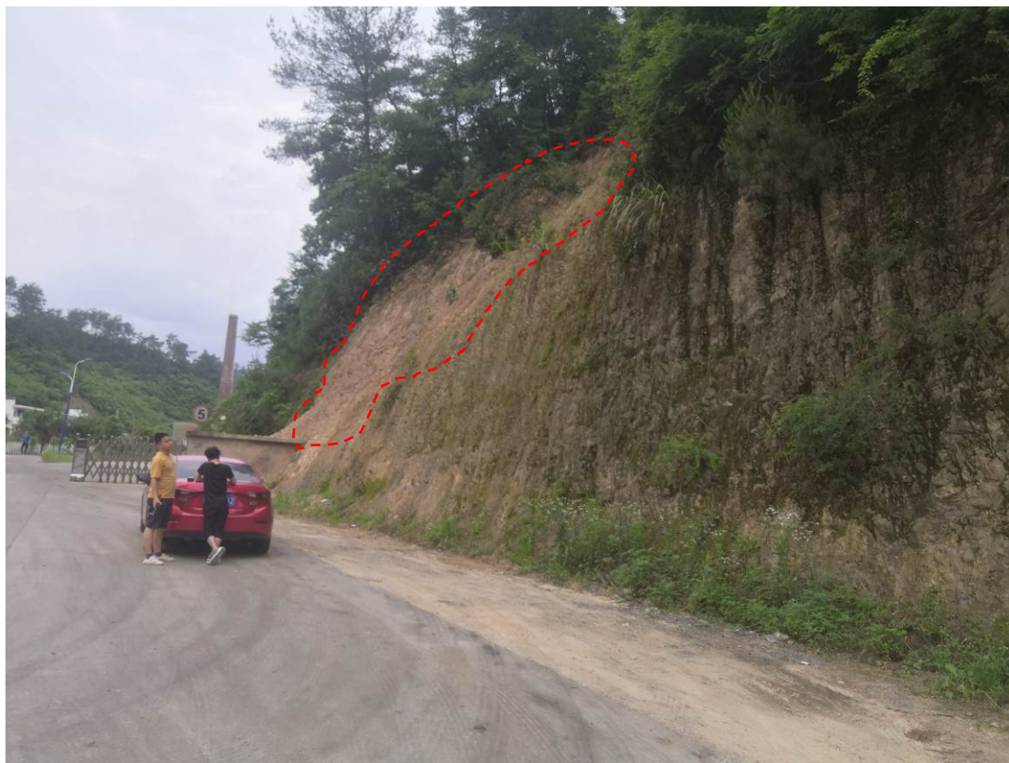
照片 3.2 扬之南路与 S217 省道交叉口北侧 800 m 道路切坡崩塌
