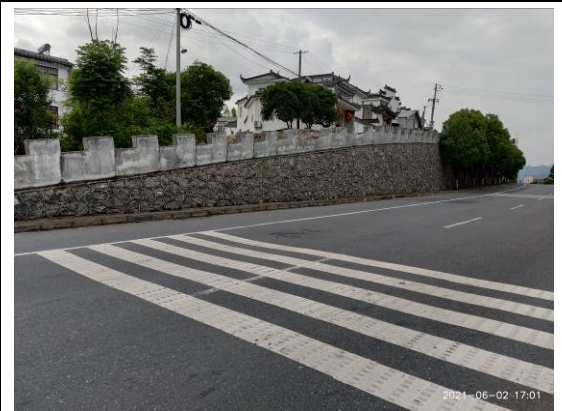
照片 4.3 扬之南路道路切坡（浆砌石挡墙）
