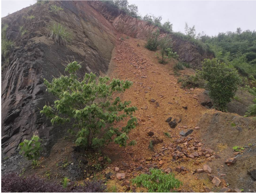
照片 3.1 鄞山路南段西侧边坡崩塌
