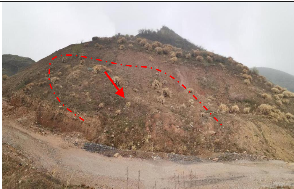
图 2-6 B 区东侧堆土区垮滑现状图
