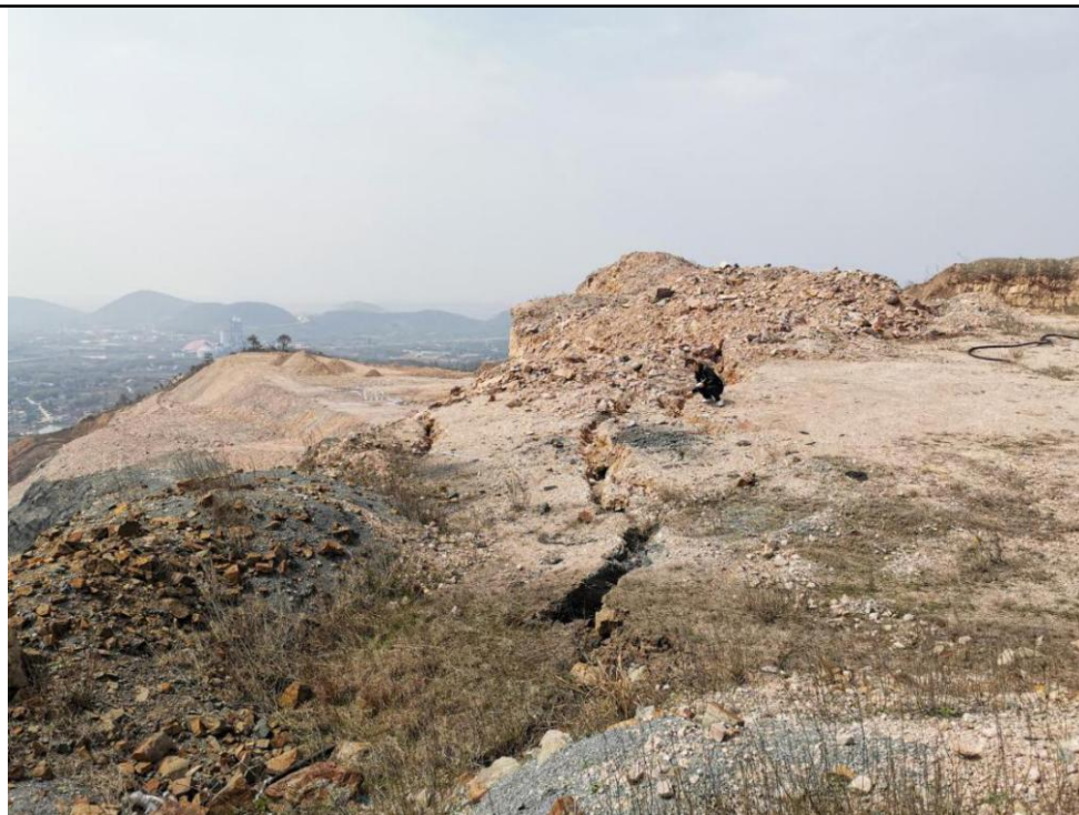
图 2-4 +300 平台裂缝现状图
