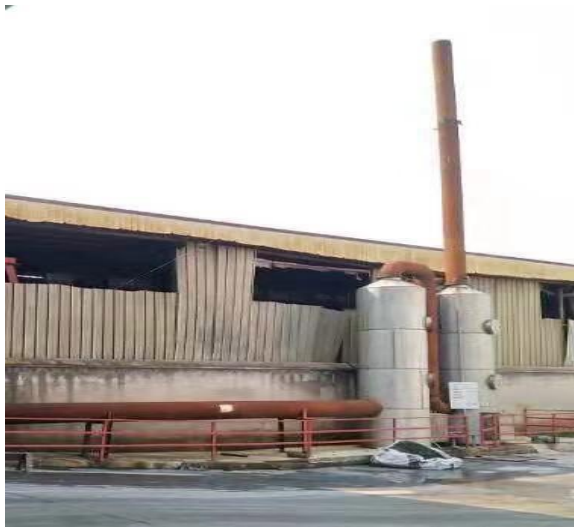
退火炉“二级水喷淋”处理设施
