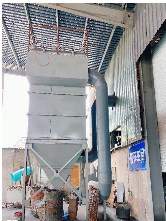
精炼炉炉渣破碎废气处理设施（1#排气筒）
