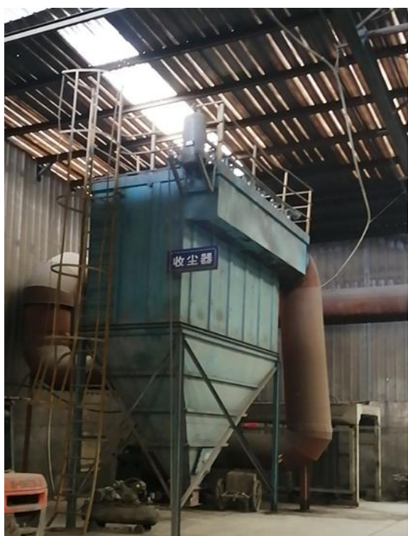
制砖车间废气处理设置（3#排气筒）
