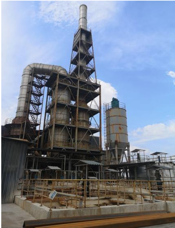
粗炼炉废气处理设施（5#排气筒）
