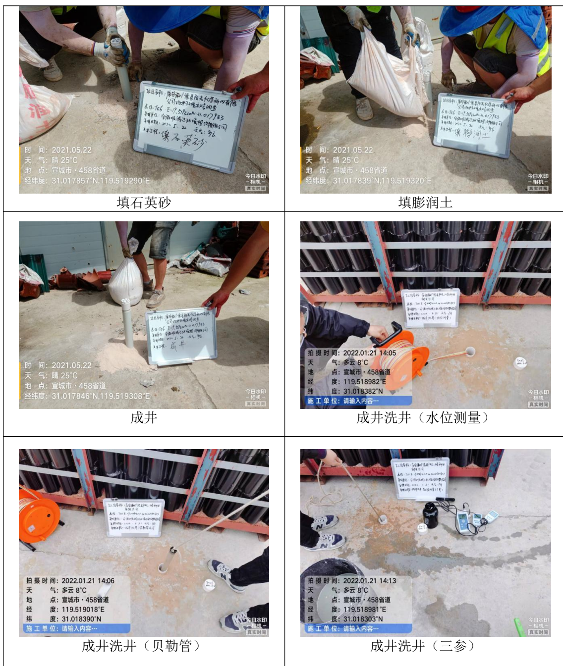
图 4-7 地下水监测井施工图
