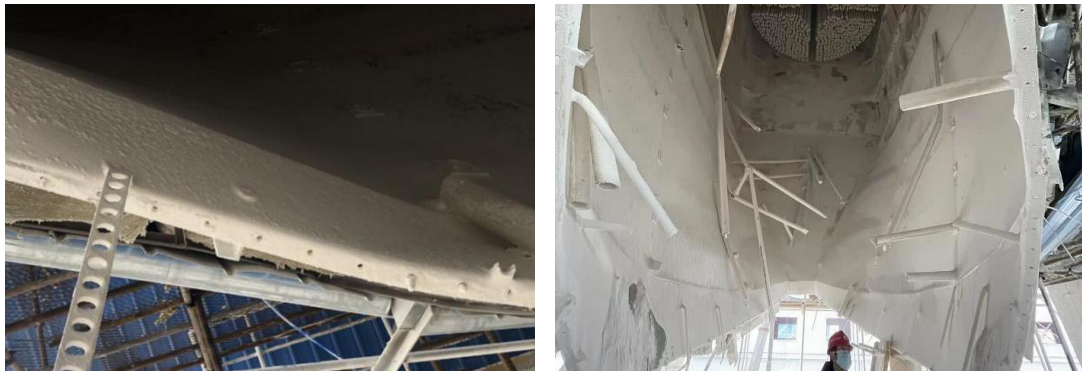
图 16 事故 D 灰斗底部斜槽破坏情况
