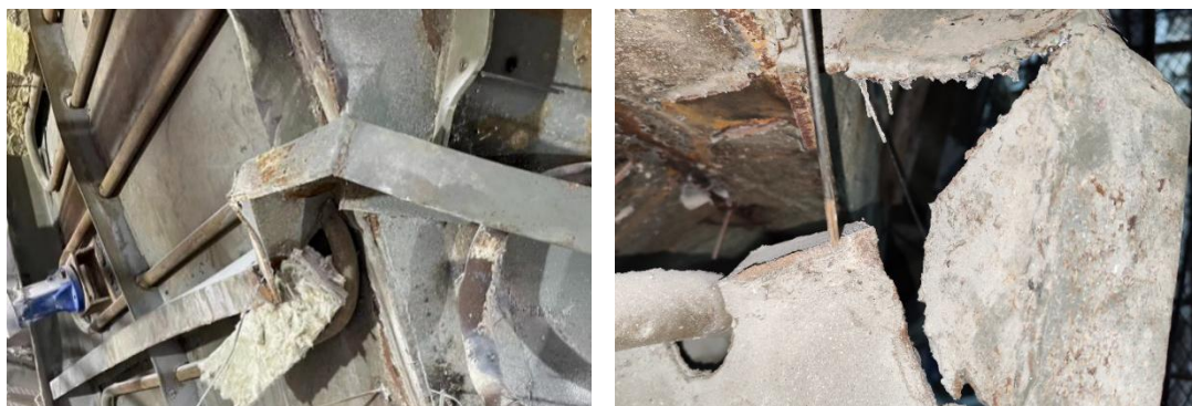
图 14 事故 D 灰斗水平加劲肋角部焊缝破坏情况
