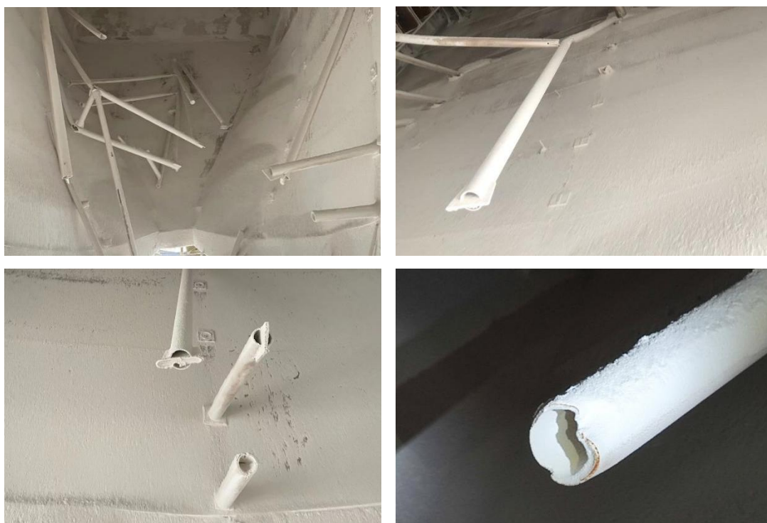
图 15 事故 D 灰斗内部管撑破坏情况
