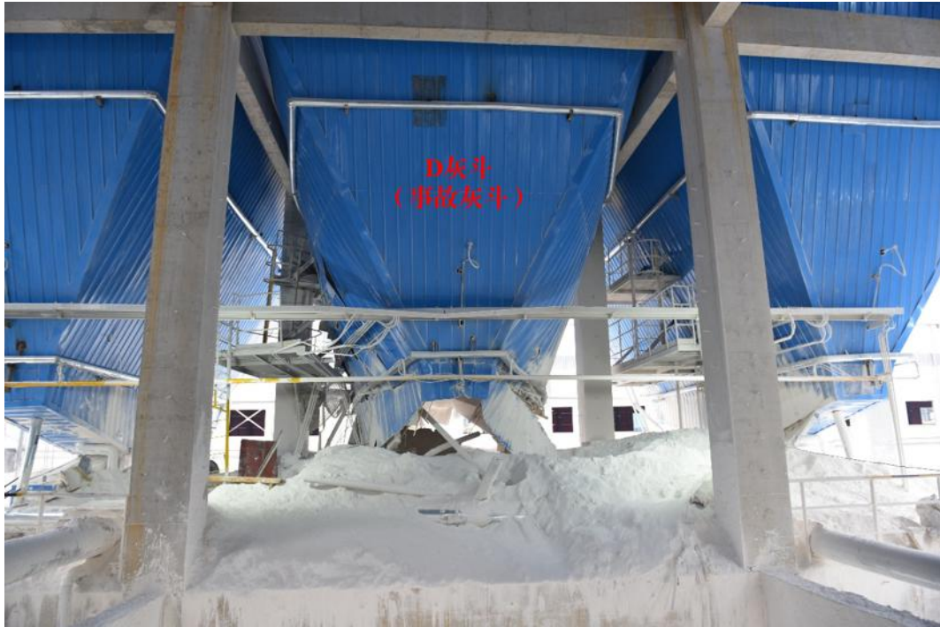
图 10 事故 D 灰斗破坏情况（由北向南拍摄）
