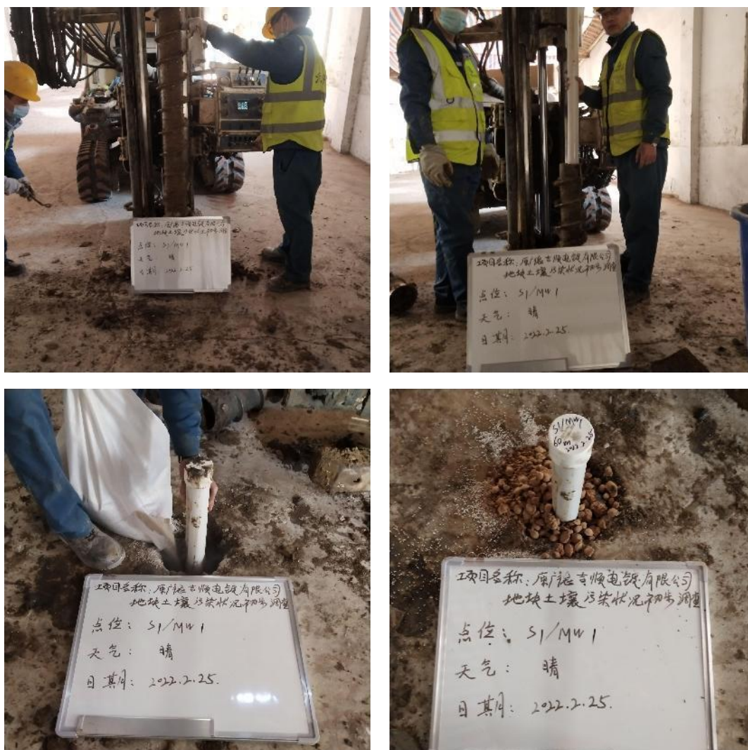
图 6-4 地下水建井工作照片
