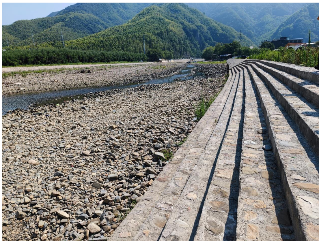
图1.2-1 汀溪河汪村左岸护岸工程现状
