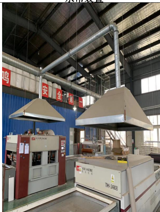
热压废气收集装置
