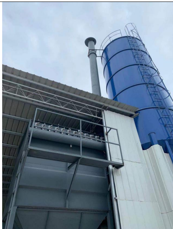
配料工段布袋除尘器+15m 排气筒
