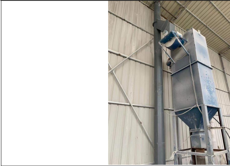
破碎工段布袋除尘器及 15m 排气筒
