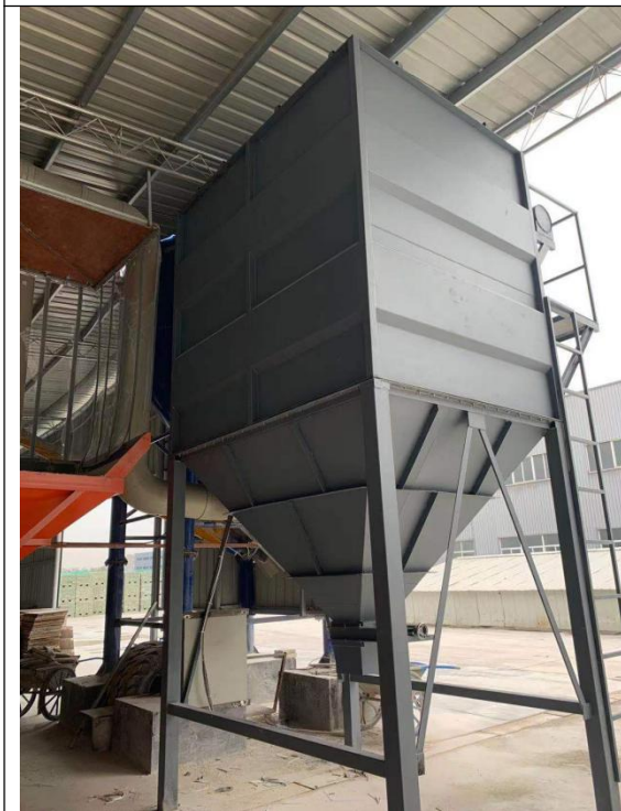
配料工段布袋除尘器+15m 排气筒
