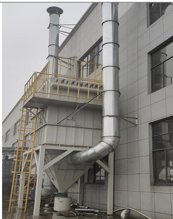
中频炉废气处理装置（布袋除尘器）+15m 排气筒
