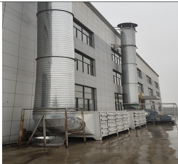
覆膜砂铸造、油漆、浇铸废气处理装置（二级活性炭吸附装置）+15m 排气筒
