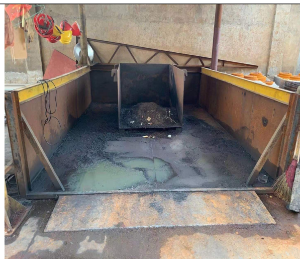
2#车间西侧含切削液清渣暂存区及废切削液暂存池（地下，1.5m×1.5m×1.5m）
