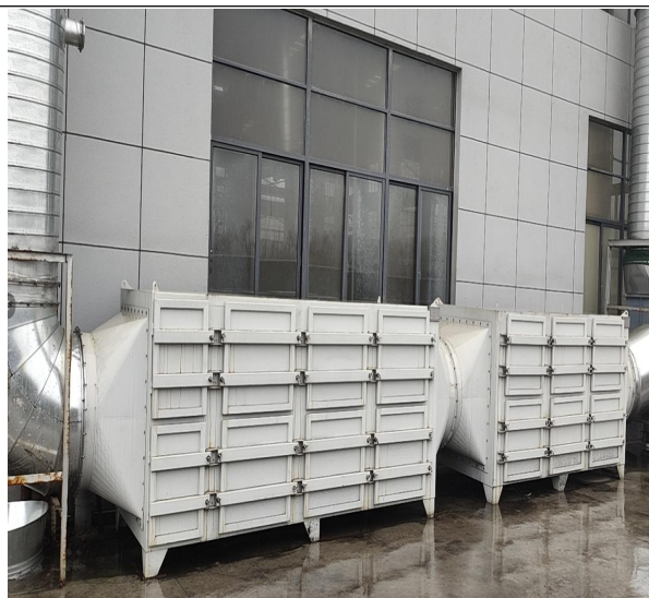
覆膜砂铸造、油漆、浇铸废气处理装置（二级活性炭吸附装置）+15m 排气筒
