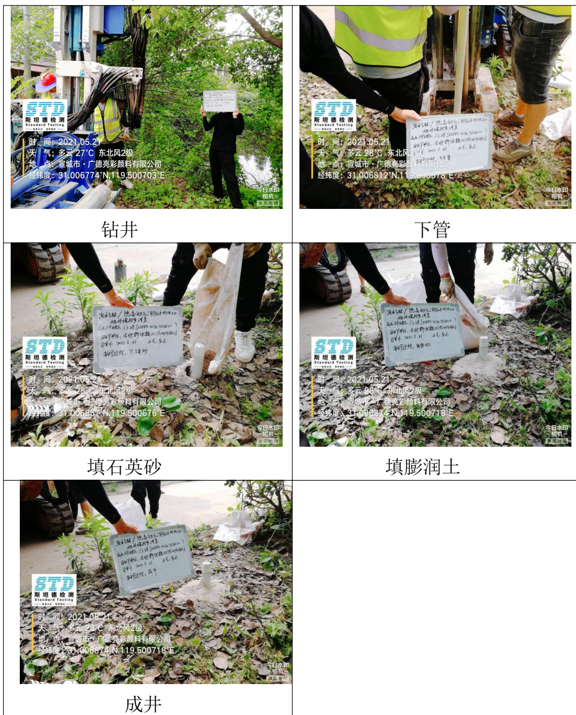
图 6-4 地下水监测井施工图
