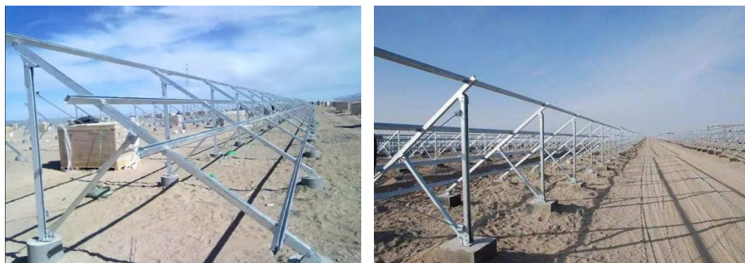
图 2-5 固定式、平单式光伏支架示意图
